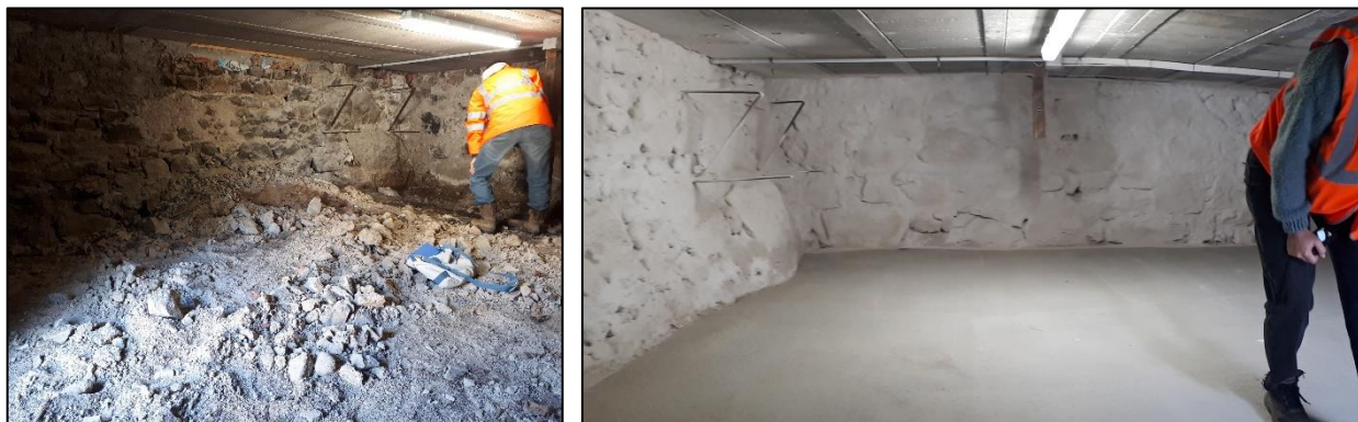
Figure 10. Vues d'une des caves avant les travaux (à gauche) et après travaux (à droite) (source BRGM)
